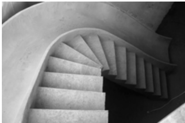
Рис. 1. Лестница монолитного железобетона
